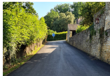
Réfection du chemin d'accès au parking de la Dîme
